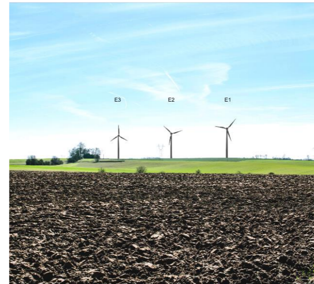
Montbréchain (02) – Parc éolien de 6,9 MW autorisé
